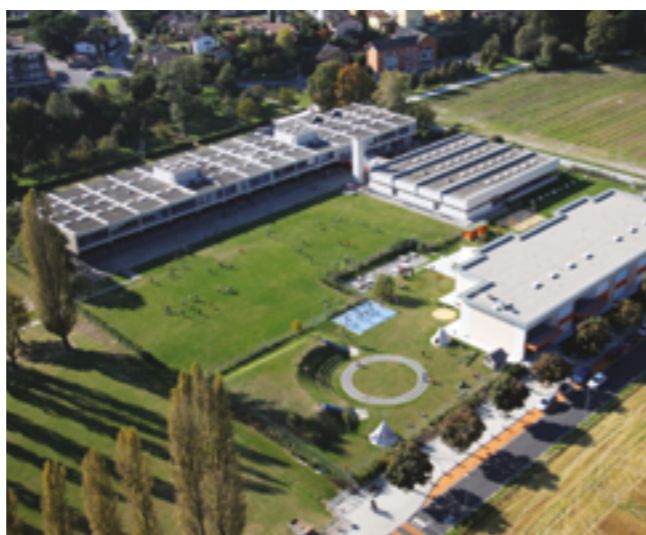
In alto: Losone vista dall'alto Sopra: l'istituto scolastico comunale
